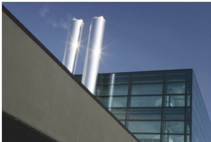
Aufgrund der erforderlichen hohen Luftwechselraten zählen Zu- und Abluftventilatoren in Pharmaunternehmen oft zu den die größten elektrischen Verbrauchern.
