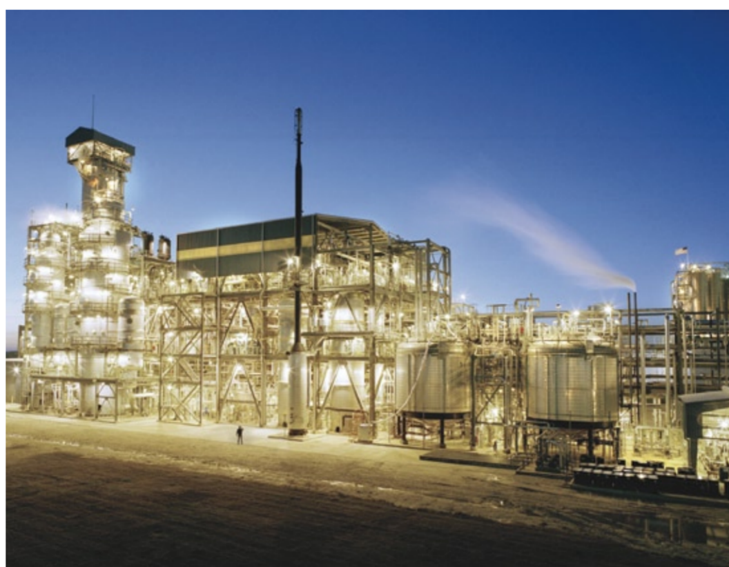
VonderEnergieerzeugungbis zurBeleuchtunginchemischenProduktionsanlagen gibt es viele Ansatzpunkte für Energieeffizienzmaßnahmen.
