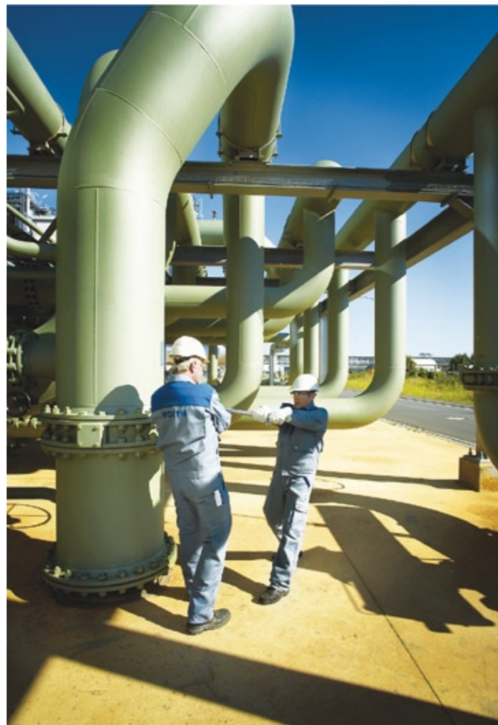
Abb. 1: Planung, Montage und Umbauten von Rohrleitungen und kompletten Prozessanlagen können Unternehmen komplett an Voith Industrial Services als Dienstleister vergeben – das Unternehmen bietet alle Leistungen aus einer Hand.
