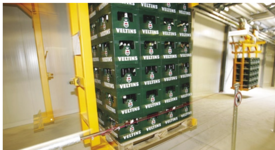
Auch bei der im Jahr 2007 installierten neuen Abfüllanlage bei Veltins wird die CAD/CAE-Software Cadison eingebunden: Die Planung aller Rohrleitungen zur Anbindung der Abfüllstationen an den Brauprozess, der Einsatzort für die Waschmaschine, den Pasteur und die CIP-Reinigung usw. wurden wie immer im Vorfeld in der externen Dienstleistung zur Feinplanung übergeben und schließlich wieder zur Dokumentation an Cadison übergeben. Im Bild: Palettengondel zwischen Abfüllung und Sortieranlage.
