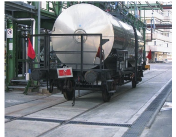
Abb.2: Rinnelemente für Gleisquerungen sowie Schwerlastbefahrbarkeit sind wesentliche Qualitätsmerkmale eines Entwässerungssystems mit entsprechendem Einsatzort. (Foto: Birco)
