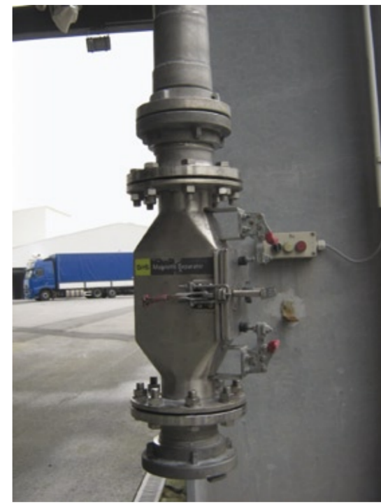
Eingesetzt wird der Rohrmagnet bei Greiwing in einer pneumatischen Förderleitung. Die Fe-Abscheidung erfolgt beim Entleeren der Silo-Fahrzeuge.
