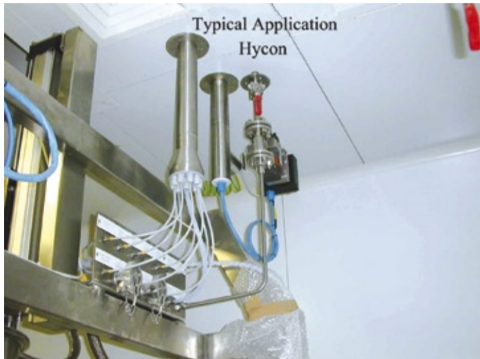
Abb. 1: Ein typische Anwendung des Kabelführungssystems Hycon von Dunreidy Engineering: Schutz von offen verlegten Kabeln in Reinräumen
