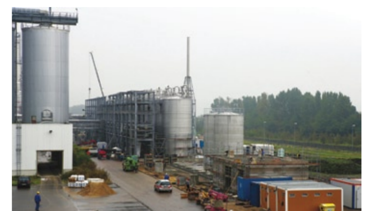
Abb. 2: Auf einer Fläche von 6.000 m 2 errichtete Köster Auffangwannen für die mehr als zehn Tanks, in denen das erzeugte Bioethanol gelagert wird. Dazu verbaute Köster rund 9.000 m 3 wasserundurchlässigen Beton, der nachträglich beschichtet wurde.
