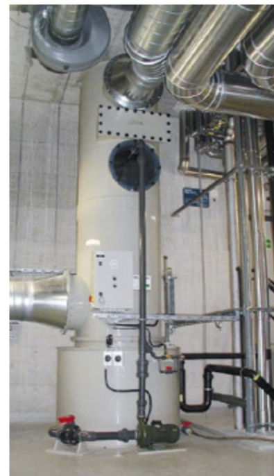
Abb.2: NH 3 -Notwäscher aus PP mit konstanter Abschlämmung
