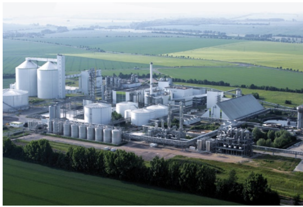
Abb. 1: In Klein Wanzleben, inmitten der Magdeburger Börde, steht die neue Bioethanolanlage der Nordzucker-Tochter Fuel 21, die rund 70 Mio. € kostete. Sie ist seit Oktober 2007 in Betrieb. Den Rohbau der Produktionsanlage sowie zwei schlüsselfertige Betriebsgebäude für die Fuel 21 errichtete das Osnabrücker Bauunternehmen Köster.
