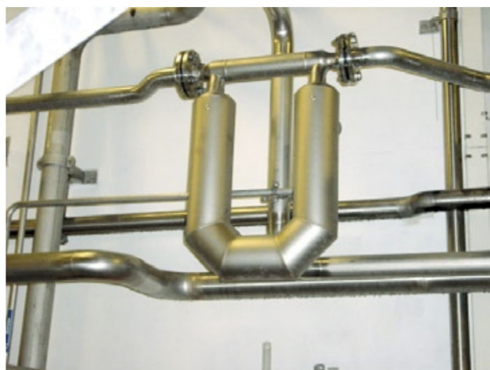
Abb. 1: Der dänische Lebensmittelhersteller Aarhus United nutzt Micro Motion Coriolis-Messgeräte mit Foundation Fieldbus-Regelkreisen in seiner neuen Pflanzenöl-Anlage. Dichtemessungen werden in vielen Branchen genutzt, um Blending-Prozesse zu überwachen und zu regeln.
