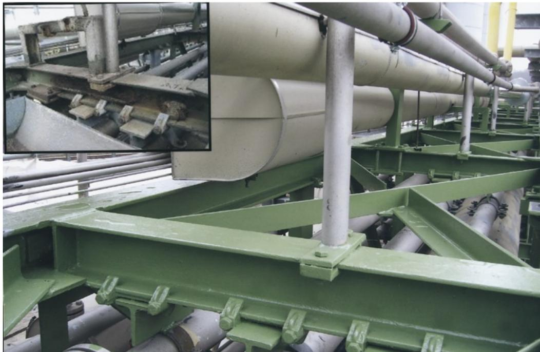
Die sanierte Rohrbrücken RB-B9 vorher (kleines Bild) und nachher; die Rohrbrücke wurde für künftige Aufgaben auch mit neuen Obergurten verstärkt.
