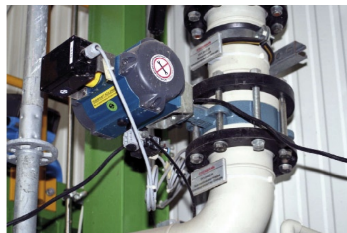
Antrieb für eine Absperrklappe
