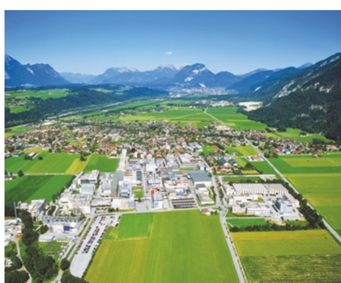
Auf dem 270.000 m 2 großen Firmengelände des Werks Kundl von Sandoz in Österreich sind rund 2.400 Mitarbeiter (von insgesamt etwa 2.800) tätig, davon etwa 470 in Forschung und Entwicklung. Neben den Produktionsanlagen sind in Kundl auch die Logistik, Ingenieurtechnik, Registrierung, Qualitätssicherung sowie zahlreiche administrative Funktionen beheimatet.
