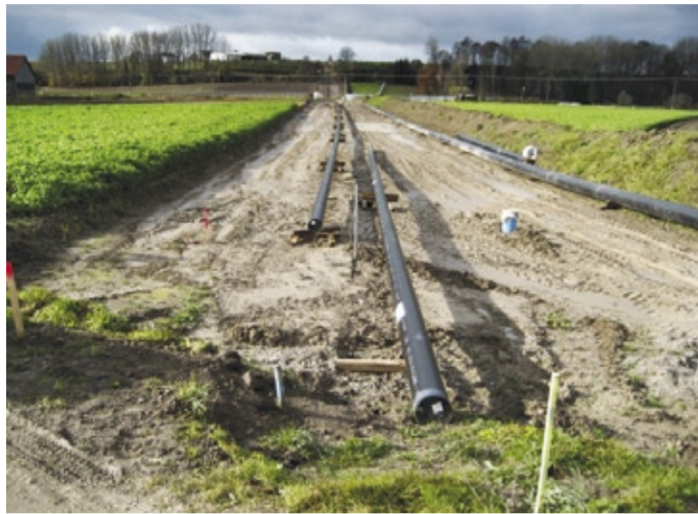
Abb. 1: Zügig voran kommt der Bau der Ethylen-Pipeline Süd in Bayern. Im Bild Rohr im Markt Pförring, Ortsteil Wackerstein, die für die Parallelverlegung gemeinsam mit der Pipeline der Bayernoil vorbereitet wurden.
