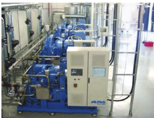
Abb. 1: Moderne Druckluftstation mit Turbokompressoren von Almig Kompressoren.
