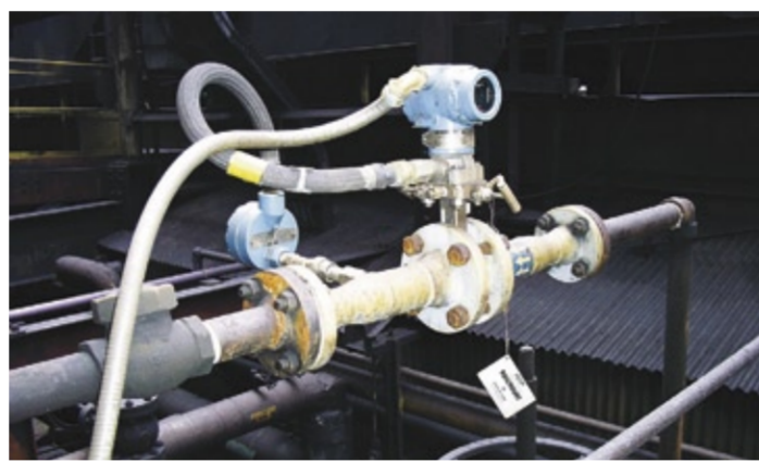
Abb. 1: Die Wirkdruck-Durchflussmessung bei Geräten mit 4-Loch-Blende kann kurz vor oder hinter den Rohrkümmern installiert werden; sie erlaubt Ein- und Auslaufstrecken von nur zweifachem Innendurchmesser des Rohres (2 D).
