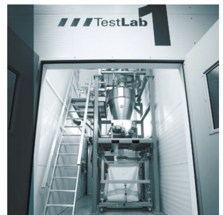
Blick in eines der vier Testlabore im neuen Testcenter von Schenck Process in Darmstadt. Drei der Testlabore enthalten unterschiedliche Einrichtungen für die praxisnahe Befüllung der Dosierer mit Big Bags oder pneumatischer Förderung sowie für die Rückförderung. In dem vierten, beheizbaren Testlabor können unterschiedliche Umweltbedingungen simuliert bzw. die Umgebungsbedingungen in heißen Ländern nachempfunden werden.
