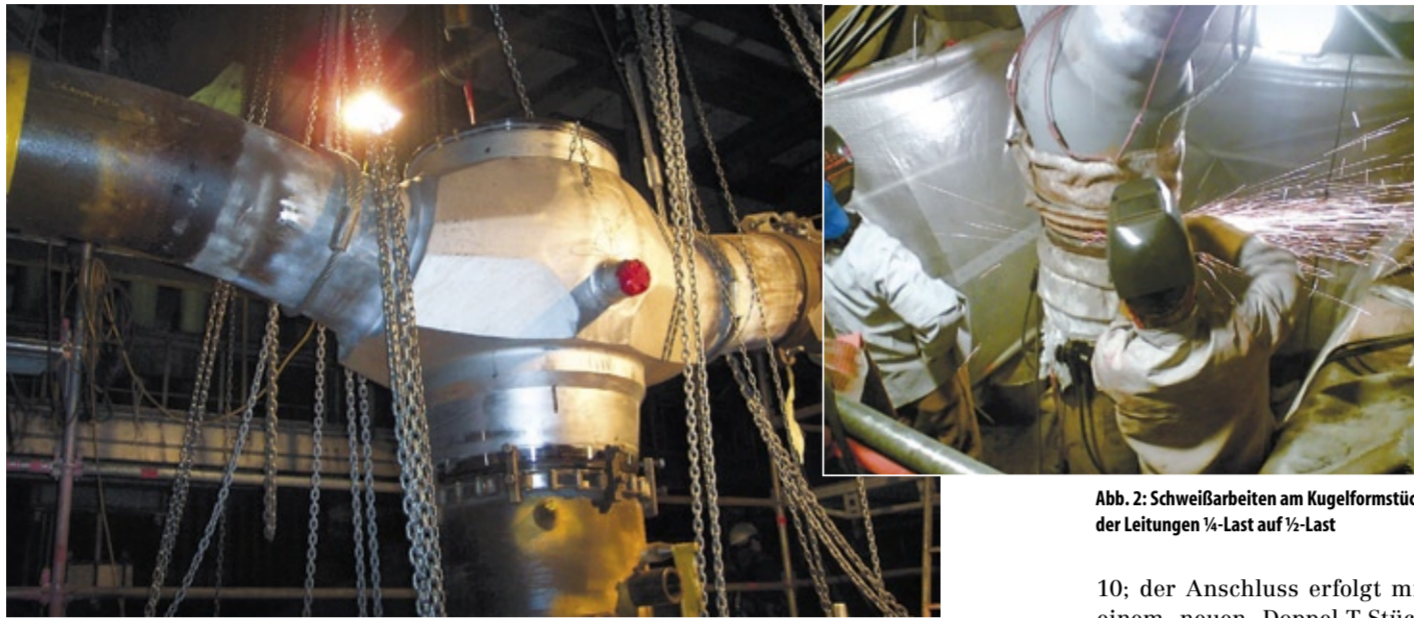
Abb. 1: Formstück Kreuzventil
