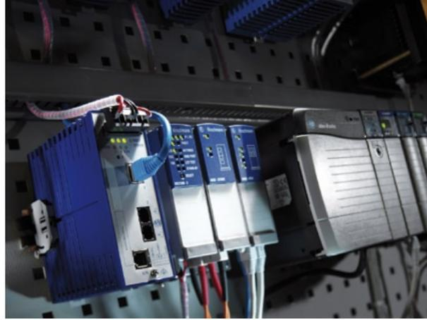
Abb. 3: Mit industrietauglichen Security-Systemen können Produktionsnetze abgeschottet werden. Das Bild zeigt einen EAGLE (links), über den ein Switch und eine Steuerung angebunden sind.
