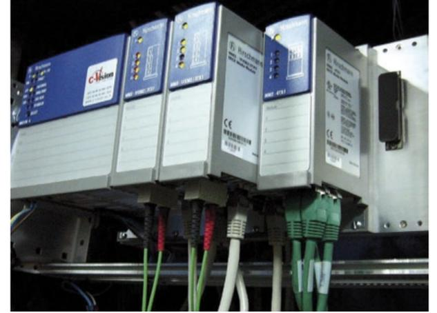
Abb. 4: Das modulare MICE-Switch-System, das mit ATEX-zugelassenen Medienmodulen bestückt werden kann, ermöglicht die Erweiterung des Ethernet-Netzwerkes über LWL-Kabel bis in die Ex-Zone 1.
