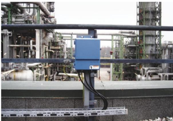
Ein Einsatzgebiet für Wireless-Gerätetechnik: Messung des Saugdrucks an einer Pumpe – die Messwerte werden zusammen mit weiteren Messwerten aus der Anlage zur vorausschauenden Instandhaltung bei der BP Gelsenkirchen herangezogen.
