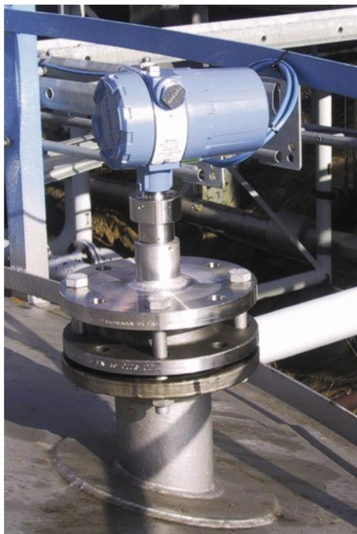
Abb. 3: Trotz Einbauten und eines abgerundeten Behälterbodens wird der Füllstand mit Radar problemlos und ohne Störreflexionen über den gesamten Bereich kontinuierlich gemessen (Geführte Mikrowelle – GWR – Rosemount Modell 3300).
