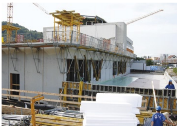
Abb. 3: Stand des Bauprojektes im Juli 2007: Rohbau Produktion Erdgeschoss Gebäudeteil 1
