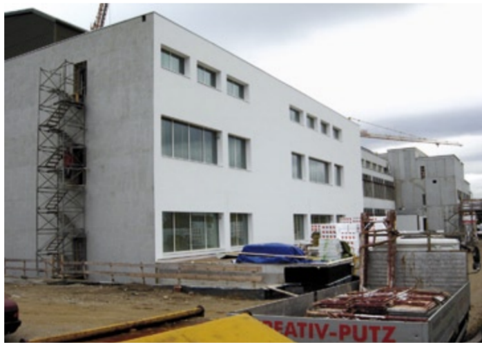
Abb. 4: Stand des Bauprojektes im November 2007: Rohbau Produktion Gebäude 1. Wärmedämmverbundsystem an Fassade fertig gestellt, Dach montiert.
