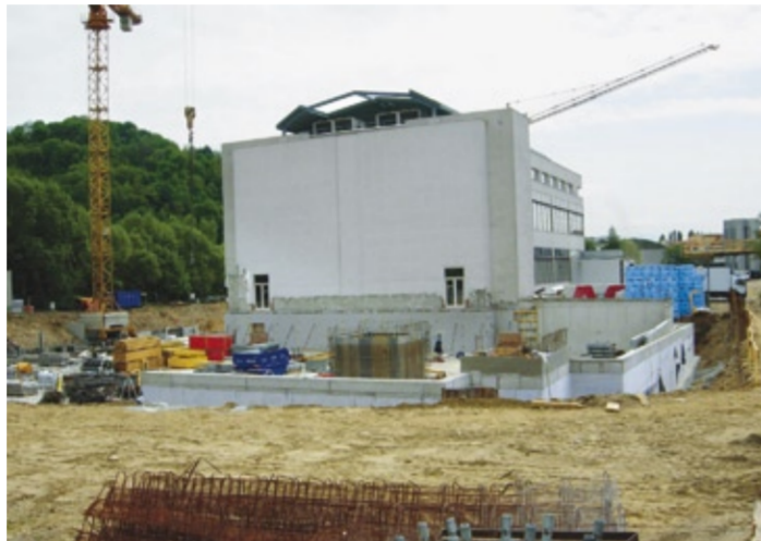
Abb. 2: Stand des Bauprojektes im Mai 2007: Rohbau Keller Gebäudeteil 1
