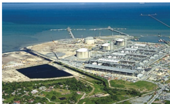
Mit dem AMS Equipment Performance Monitor und den CSI 4500 Machinery Health Monitor der AMS-Suite von Emerson werden bei Atlantic LNG in Trinidad/Tobago eingesetzt. Beide Systeme ergänzen einander und liefern gemeinsam eine Leistungs- und die Zustandsüberwachung mit vorausschauender Diagnose von zentralen Assets für die Verarbeitung von flüssigem Erdgas (LNG) auf vier Produktionslinien.
