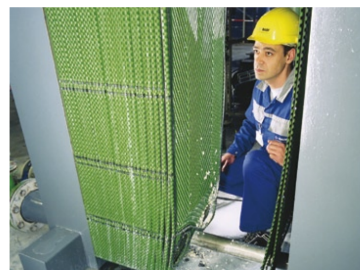
Inspektion von Wärmeaustauscherplatten mit FEP-Antihafbeschichtung von BASF nach acht Jahren Standzeit
