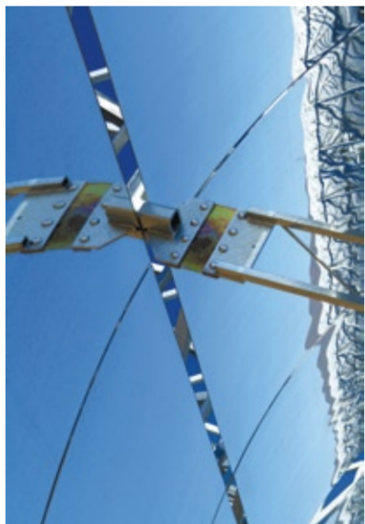
Abb. 2: Die auf den Spiegel auftreffenden Sonnenstrahlen werden mit einer Genauigkeit von über 98% auf das Absorberrohr in der Brennlinie des Kollektors reflektiert.
