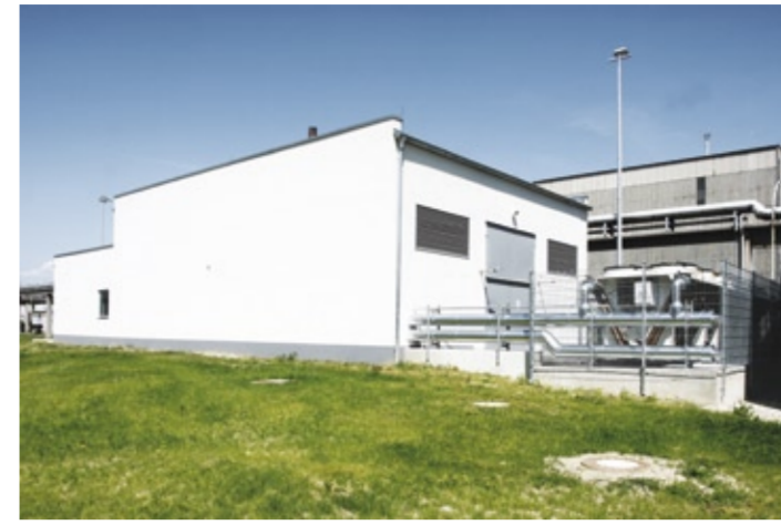
Die Schraubenkompressoren und die Schaltschränke in der neuen Druckluftstation sind wassergekühlt. Das Kühlwasser wird in einem autarken und geschlossenen Kreislauf mit externer Rückkühlanlage außerhalb des Gebäudes zurückgekühlt.
