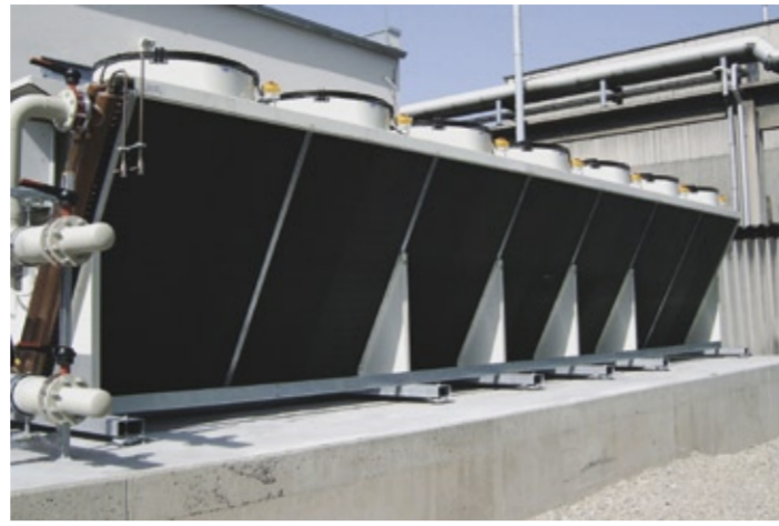
Die Schraubenkompressoren und die Schaltschränke in der neuen Druckluftstation sind wassergekühlt. Das Kühlwasser wird in einem autarken und geschlossenen Kreislauf mit externer Rückkühlanlage außerhalb des Gebäudes zurückgekühlt.
