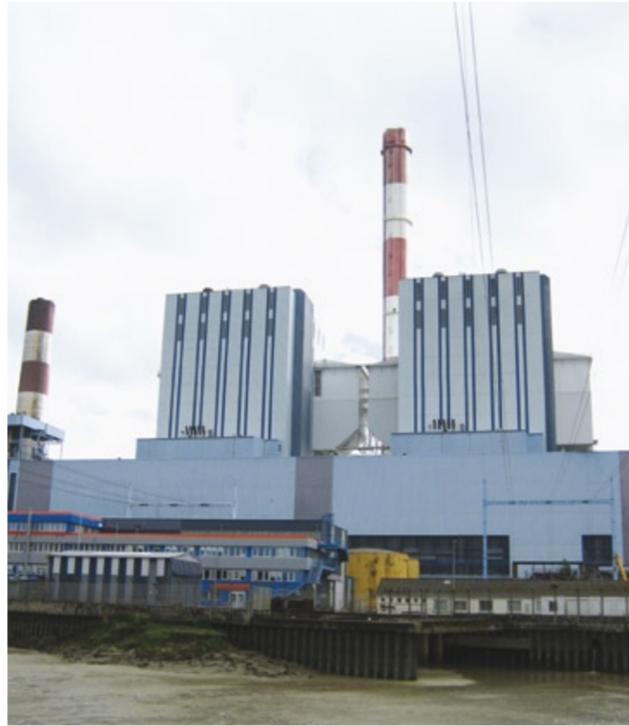
Das 34 km westlich von Nantes in Cordemais gelegene Wärmekraftwerk der Electricité de France (EDF)
