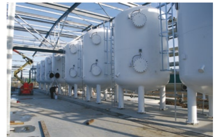
Die neue Aufbereitungsanlage, die Evides auf dem Gelände von Huntsman im Rotterdamer Hafen errichtet, arbeitet mit einer Kombination von Ionenaustauschern und Membranverfahren.
