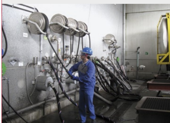
Abb. 3: Von Schloemer und RS Roman Seliger auf Stand gebracht: Sichere Abfüllung mit der TKU, mit Schlauchdrehlagern und Schlauchauflrollern
