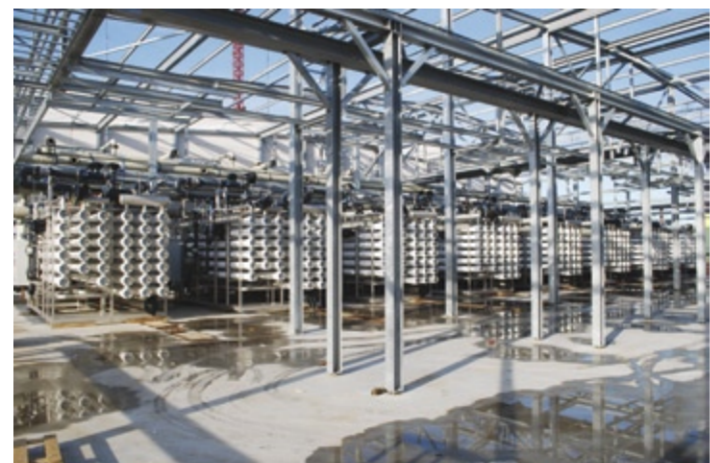
Die neue Aufbereitungsanlage, die Evides auf dem Gelände von Huntsman im Rotterdamer Hafen errichtet, arbeitet mit einer Kombination von Ionenaustauschern und Membranverfahren.
