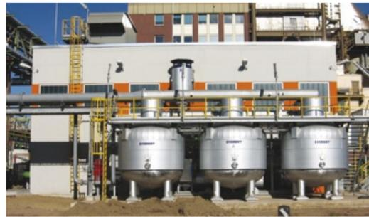
Mit einer Drei-Behälter Lufttrocknungsanlage wurde der Gesamtdruckverlust gesenkt.
