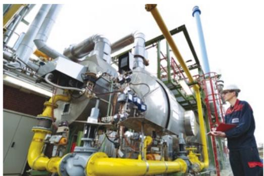
Lachgas-Spaltungsreaktor (rechts) mit Erdgasfeuerung der Brennkammer (links).
