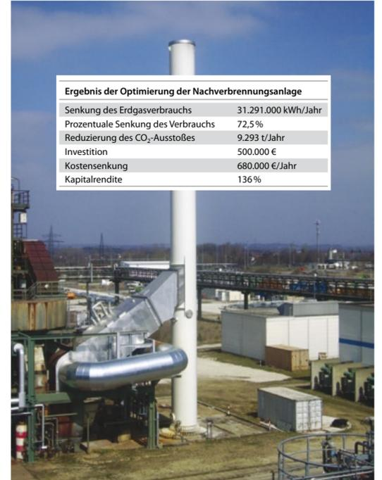
Rauchgaskamin in der thermischen Nachverbrennung am Standort Münchsmünster mit vorgeschaltetem Wärmetauscher zur Vorwärmung des Kesselspeisewassers.
