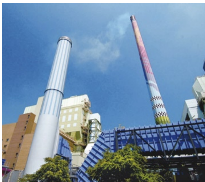
Zertifikate für Anlagen der Stromproduktion müssen Chemieunternehmen ab 2013 zu 100 % ersteigern. Im Bild ein Heizkraftwerk im Industriepark Höchst. Quelle: Infraser Höchst
