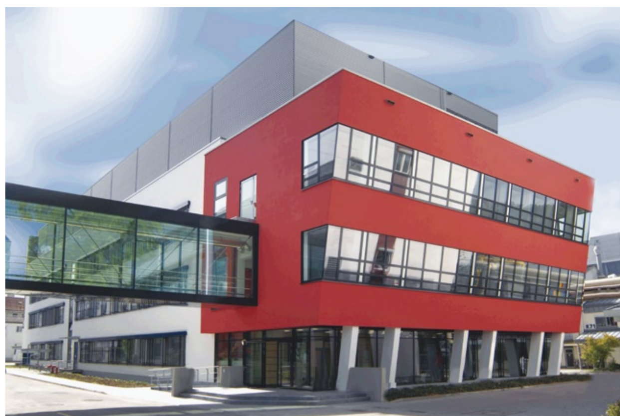
Neubau der Chemischen Entwicklung am Standort Biberach. Rund 26 Mio. € wurden während der rund einjährigen Bauphase in das Gebäude und dessen technische Ausstattung investiert.
