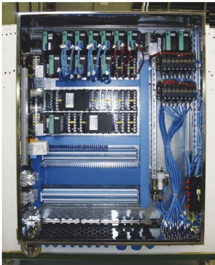
Abb. 2: Remote I/O als intelligenter Verteilerkasten
