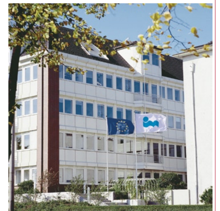
Hauptgebäude von IMCD Deutschland in Köln
