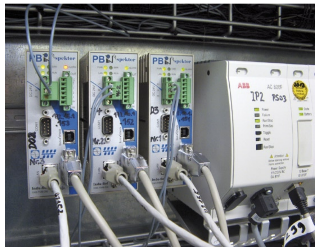
Abb. 1: Profibus-INSpektoren im Praxiseinsatz bei Ineos Melamines in Frankfurt am Main.
