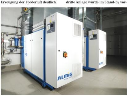
In der neuen Druckluftstation bei den Alligator-Farbwerken produzieren zwei drehzahlgeregelte Schrauber kompressoren die Arbeitsluft
