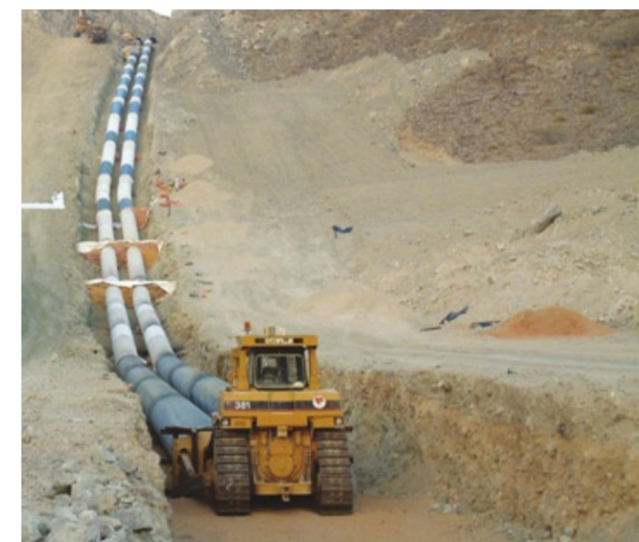
Technip Germany gehört zu den erfahrensten Unternehmen für den Bau von Pipelines in der Welt.
