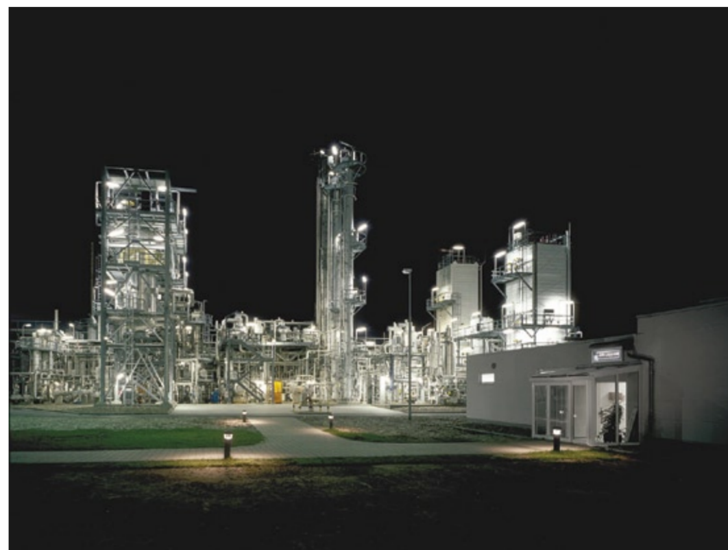
Abb. 1: Synthesegasanlage in Stade
