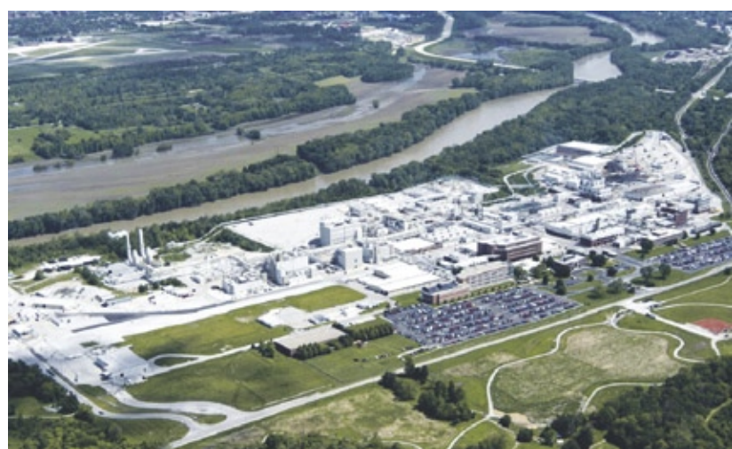
Luftaufnahme des US-Standorts Tippecanoe in Lafayette/Indiana, rund 100 km nördlich von Indianapolis, den Evonik im Dezember von Eli Lilly erwarb
