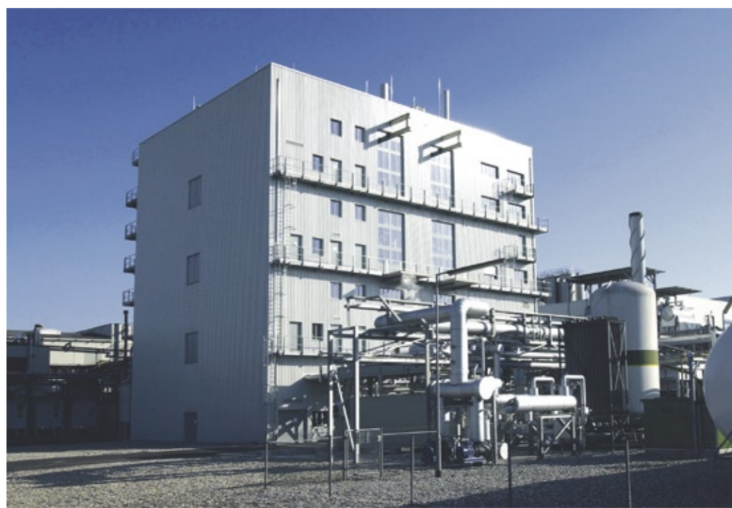
Qualitätsnachweis: Die Herstellung von Pharmawirkstoffen und anderen Feinchemikalien erfolgt nicht überall unter den guten Produktionsbedingungen, die z. B. inspezierte Anlagen wie diese bieten. Foto: CU Chemie Uetikon
