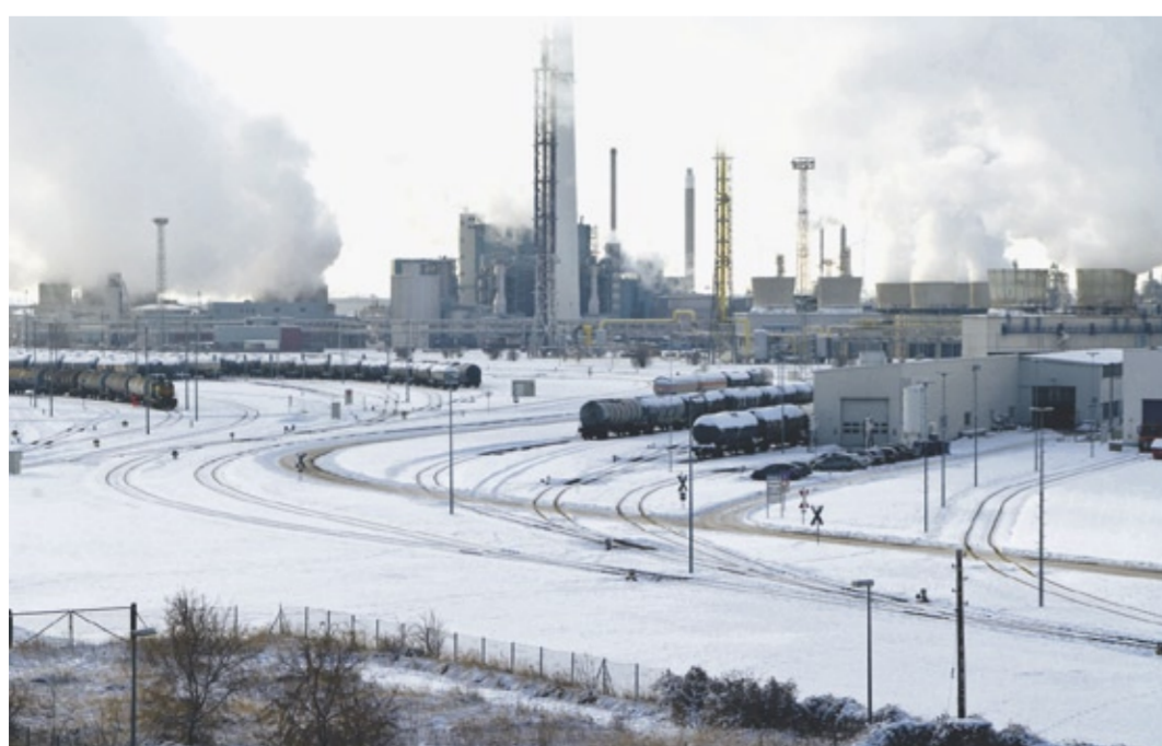
Auch während des Winters sorgt die InfraLeuna dafür, dass am Chemiestandort Leuna alles „wie geschmiert“ läuft.
