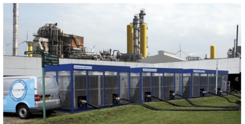
Luftgekühlte Kältemaschinen (Chiller) werden zum Rückkühlen oder Erwärmen von Prozessflüssigkeiten in der Industrie eingesetzt.
