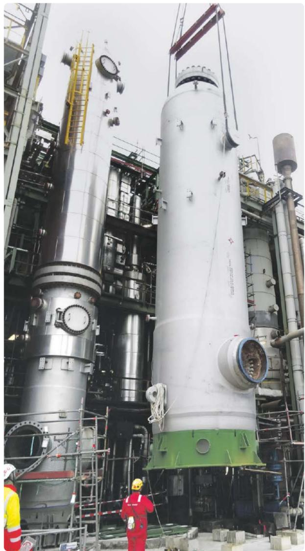
Einbau eines Vergasungsreaktors unter beengten Platzverhältnissen bei der TotalEnergies Mitteldeutschland Raffinerie in Leuna.
