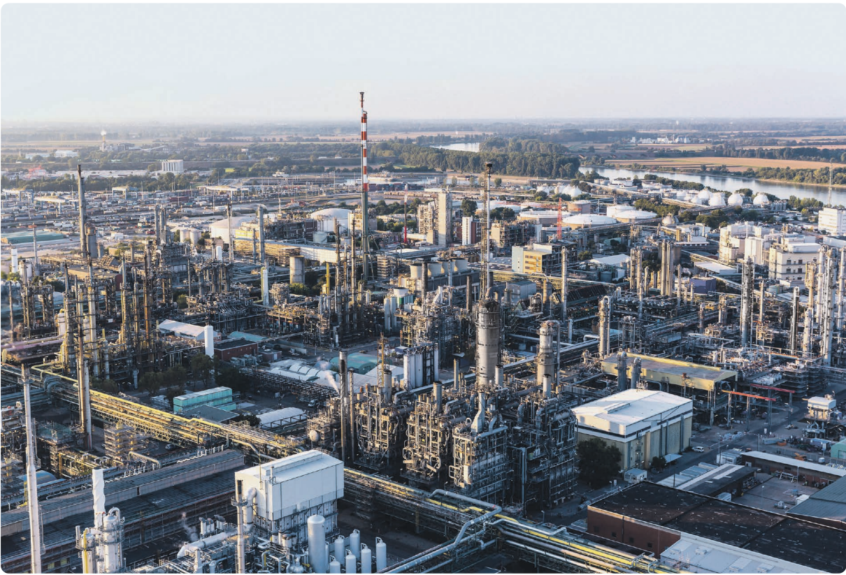
Steamcracker wie bei BASF in Ludwigshafen gehören zu den größten und aufwändigsten Produktionsanlagen der chemischen Industrie.
