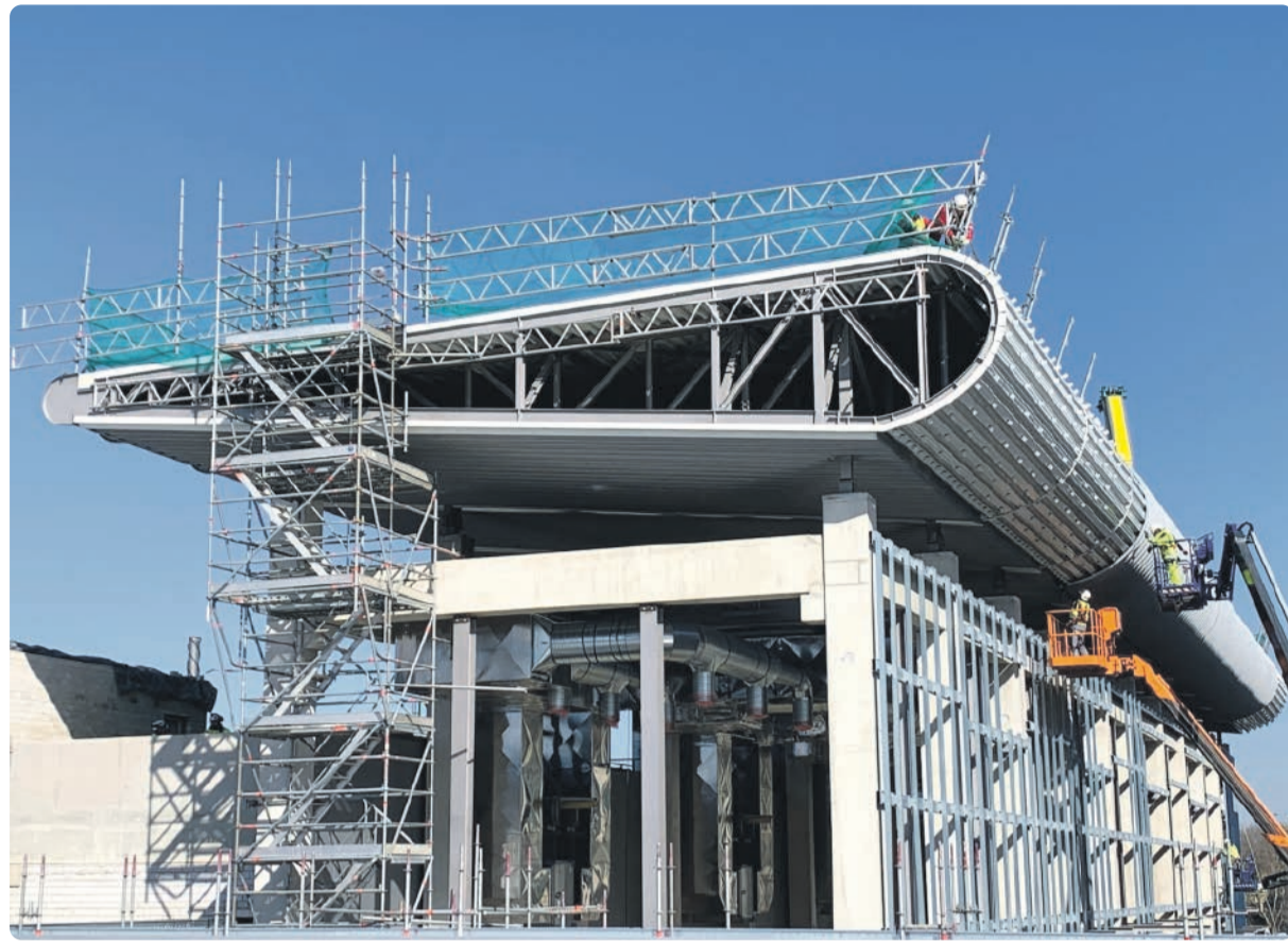
Der Shell Energy and Chemicals Park Rheinland feiert Richtfest mit dem neuen Wasserstoff-Elektrolyseur Refhyne 2.
