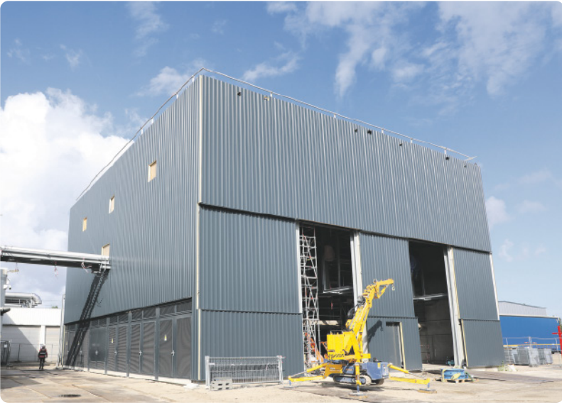
Thermische Energiespeicher schaffen die Voraussetzung, erneuerbaren Strom kosteneffizient für die Dampferzeugung nutzbar zu machen.
