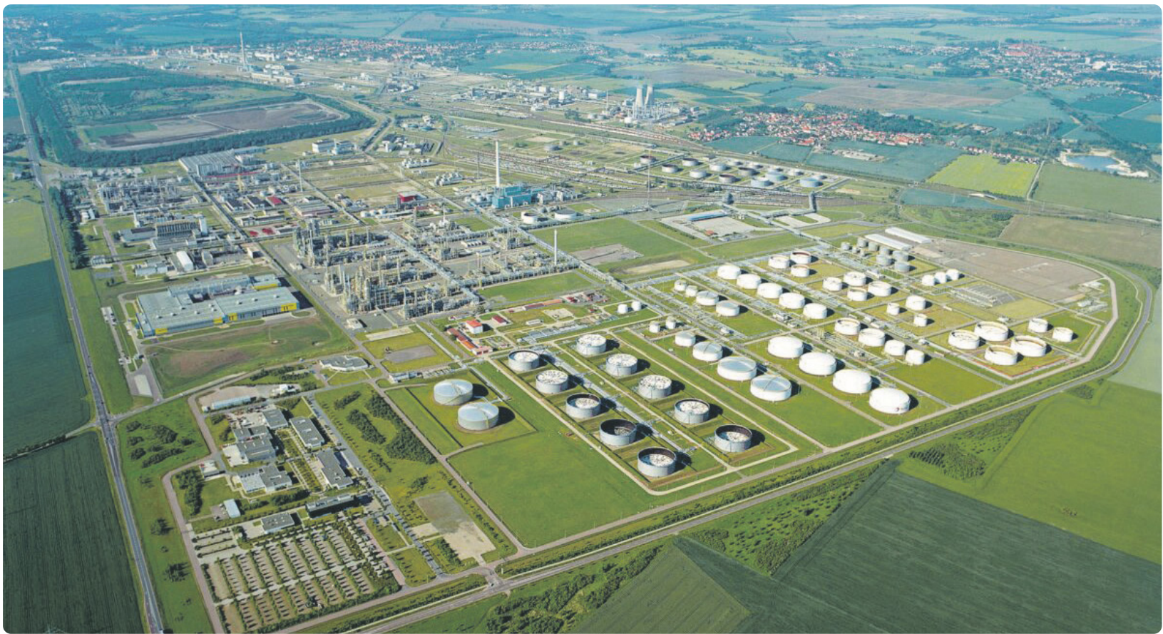
Ein Blick auf das Tanklager und die Anlagen der TotalEnergies-Raffinerie in Leuna.
