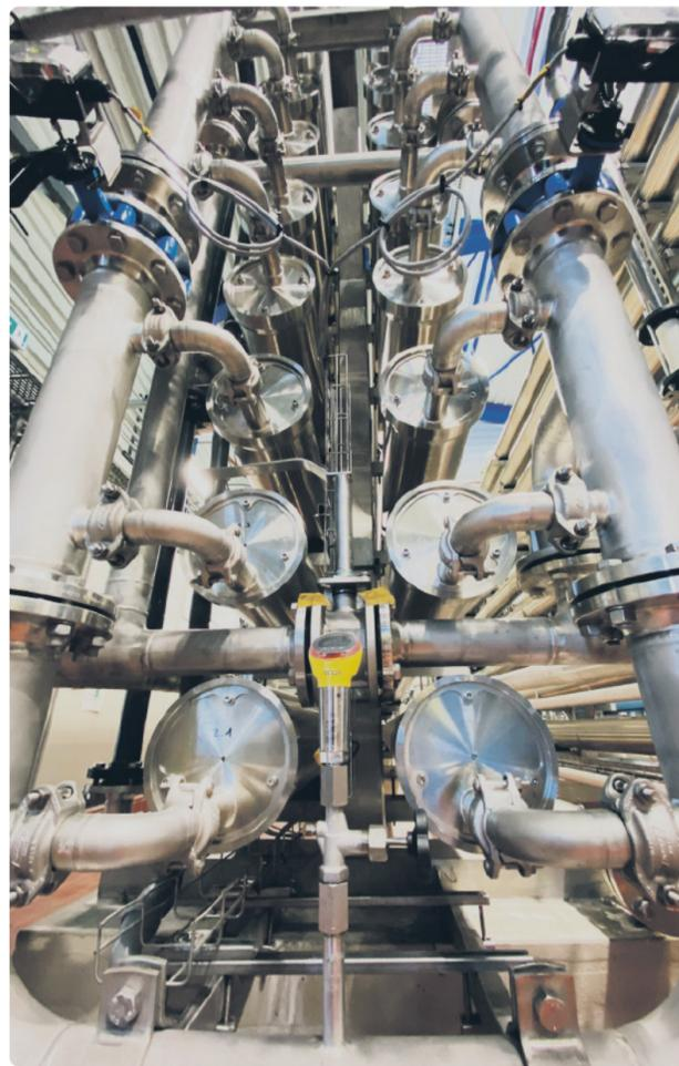
Edelstahl-Druckrohre einer Straße der Umkehrosmoseanlage.
