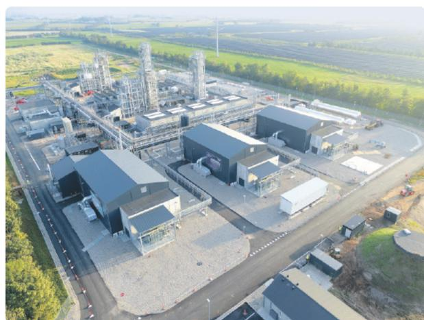
Im dänischen Kassø wurde 2025 die weltweit größte e-Methanol-Anlage von European Energy in Betrieb genommen. ReiCat lieferte eine Gasreinigungsanlage, um den Restsauerstoff aus dem elektrolytisch erzeugten Wasserstoff zu entfernen und damit für die Methanolsynthese vorzubereiten.
