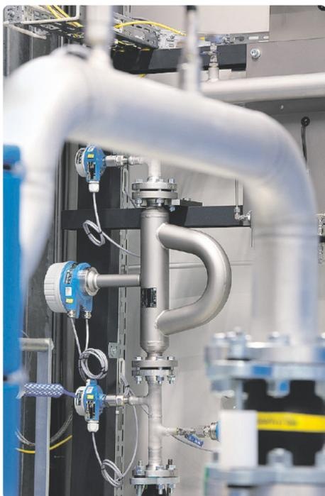
Im Ladebereich zählt jedes Kilogramm: Coriolis-Durchflussmesser sorgen für exakte CO<sub>2</sub>-Erfassung bei Transport und Verladung.
