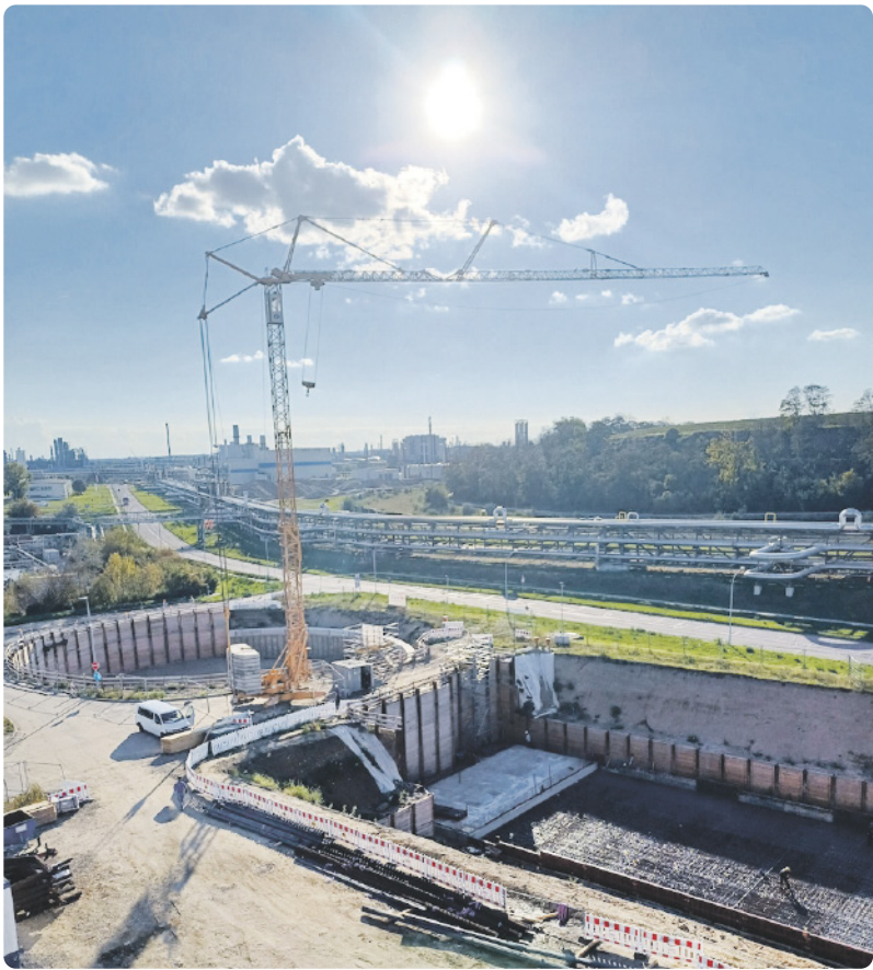
Baustelle des Erweiterungsbaus der Zentralen Abwasserbehandlungsanlage am Chemiestandort Leuna um eine dritte aerobe Abwasserbehandlungslinie.
