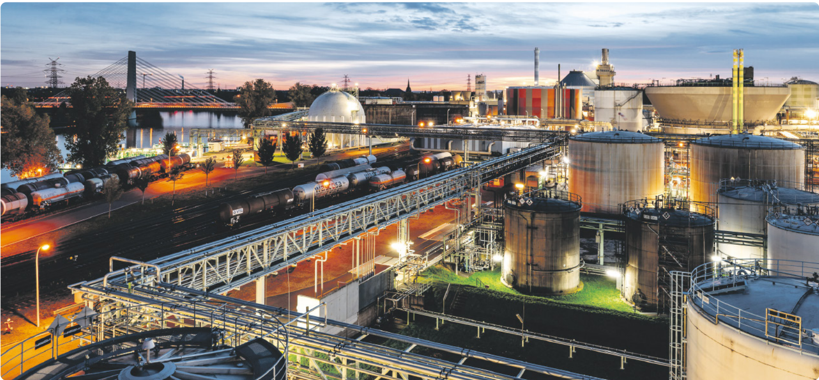
Das Tanklager, das Infraserv Logistics im Industriepark Höchst betreibt, sichert mit rund 135 Tanks, Rohrleitungen direkt zur Produktion und trimodaler Anbindung die Rohstoffversorgung und -entsorgung am Standort.
