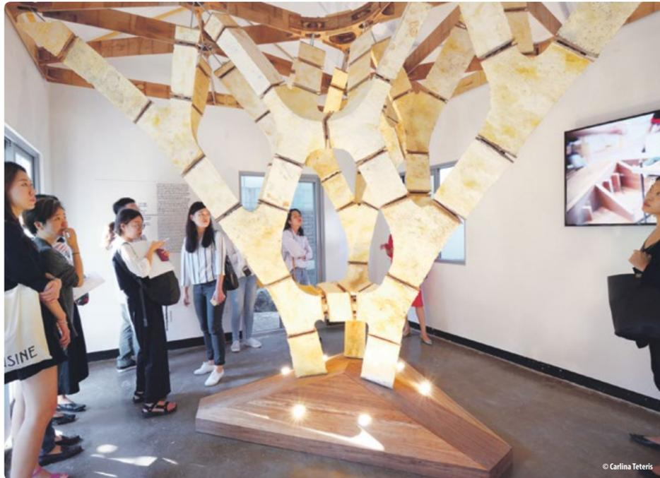
Der „Mycotree“, eine Struktur aus Pilzmyzelium und Bambus. Die Geometrie wurde mit Methoden grafischer Statik in 3D optimiert und tragfähig gemacht.
