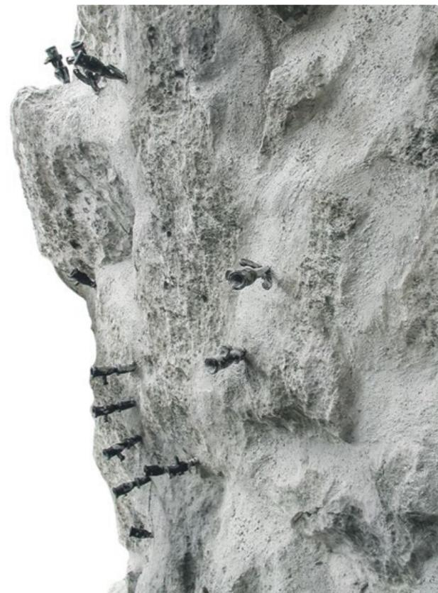
Mit Injektionsmörtel wurde der Kalksteinfelseln, auf dem der Treppenturm der Burg erbaut wurde, verpresst und so vor eindringendem Wasser geschützt.
