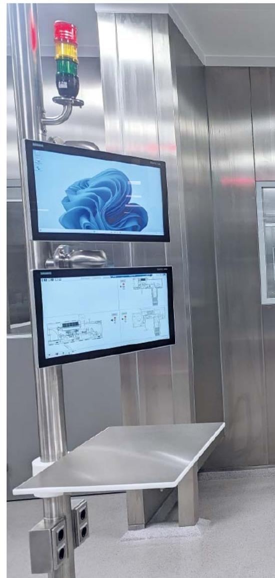
Steuereinheit (SPS), einer SCADA-Software zur Bedienung und Beobachtung des Systems und einem separaten Tool zur Erstellung von Chargenprotokollen. Alle relevanten Daten werden in einer SQL-Datenbank gespeichert, um eine umfassende und zuverlässige Datenhaltung zu gewährleisten.
