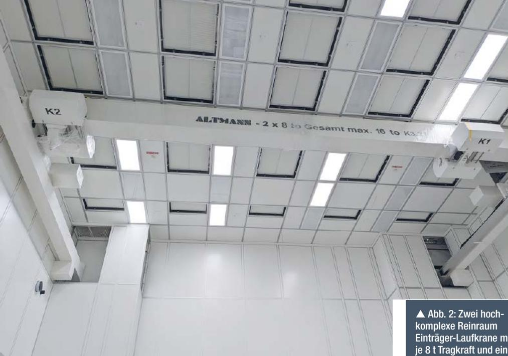
▲ Abb. 2: Zwei hochkomplexe Reinraum Einträger-Laufkrane mit je 8 t Tragkraft und einer Spannweite von 11,48 m, mit synchronisiertem Tandembetrieb von zwei Kranen und vier Hubwerken und halbautomatischer Positionierung
