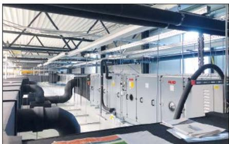
**Abb. 4:** Dezentrale Lüftungsgeräte auf der Reinraumdecke garantieren kurze Luftwege und somit optimale Energieeffizienz.
