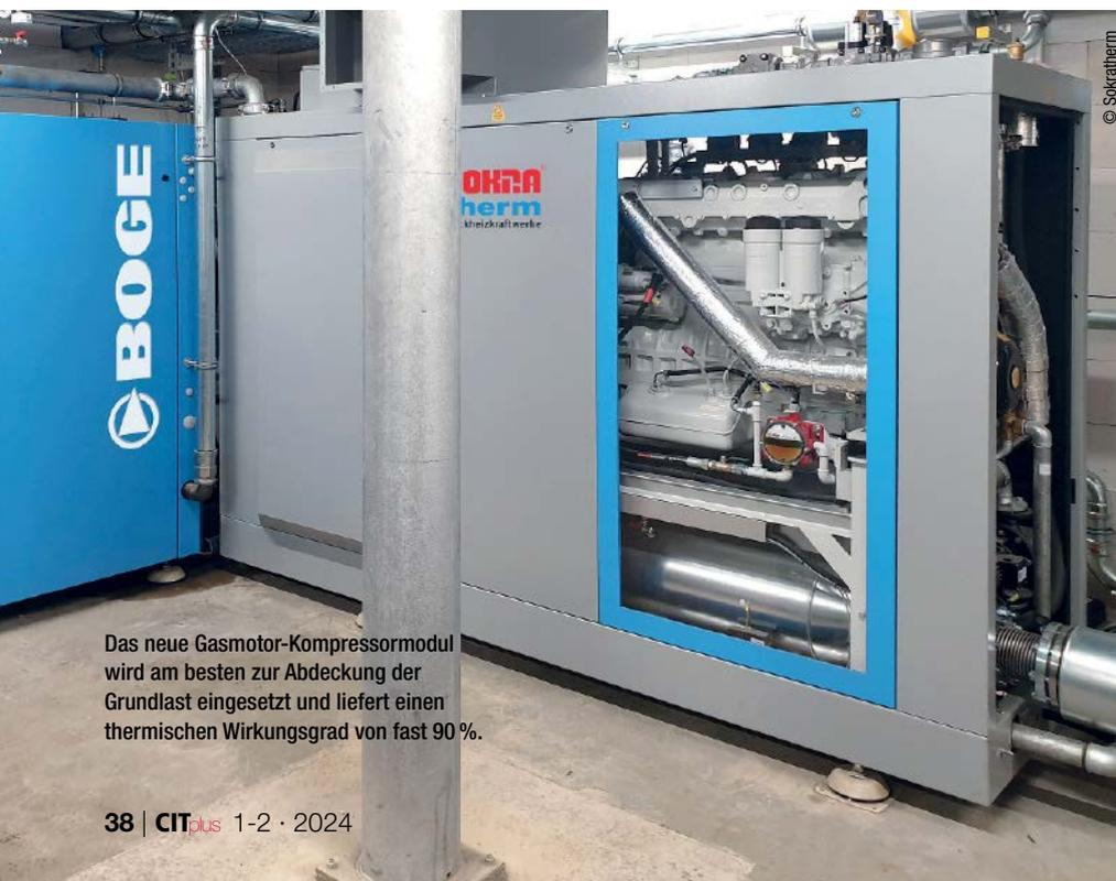
Das neue Gasmotor-Kompressormodul wird am besten zur Abdeckung der Grundlast eingesetzt und liefert einen thermischen Wirkungsgrad von fast 90 %.
