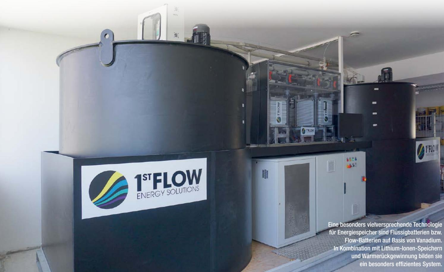
Eine besonders vielversprechende Technologie für Energiespeicher sind Flüssigbatterien bzw. Flow-Batterien auf Basis von Vanadium. In Kombination mit Lithium-Ionen-Speichern und Wärmerückgewinnung bilden sie ein besonders effizientes System.
