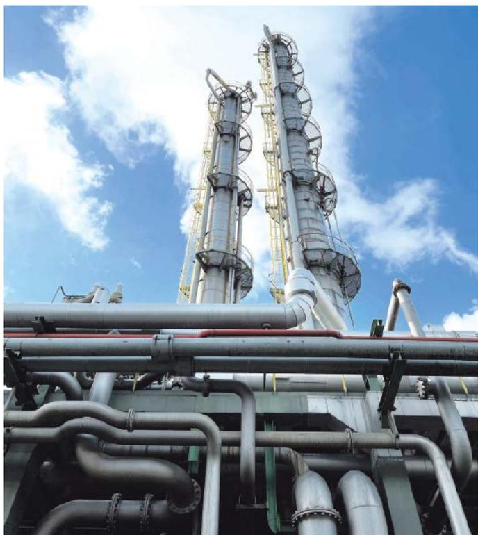
Mittels eines Smart Safety Tests an sicherheitsrelevanten Absperrklappen konnte Evonik in Marl die Verfügbarkeit einer Propen-Destillation erhöhen und die Zyklen zwischen Anlagenstillständen von einem auf drei Jahre verlängern.
