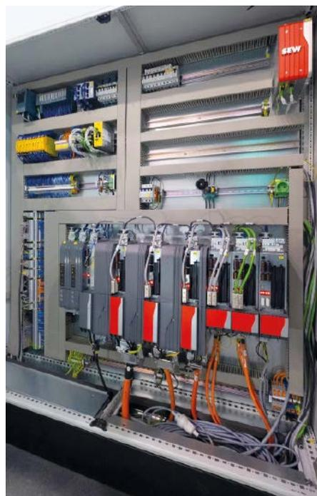
Abb. 5: Das kompakte Mehrachssystem Movidrive modular besteht aus Versorgungsmodulen, Rückspeisemodulen sowie Einachs- und Doppelachsmodulen. In diesem Schaltschrank ist energetisch zwischen der Einspeiseeinheit und den Antriebsreglern die Speichereinheit Movi-DPS für die Zwischenpufferung freierwerdender Energie platziert.
